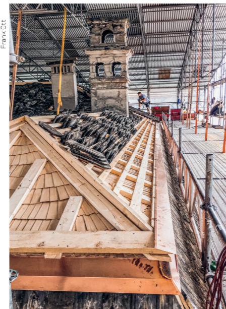
Der Dachstuhl wurde wo möglich repariert oder in traditionellem Handwerk erneuert. Die bauzeitlichen Tonziegel wurden wiederverwendet.
